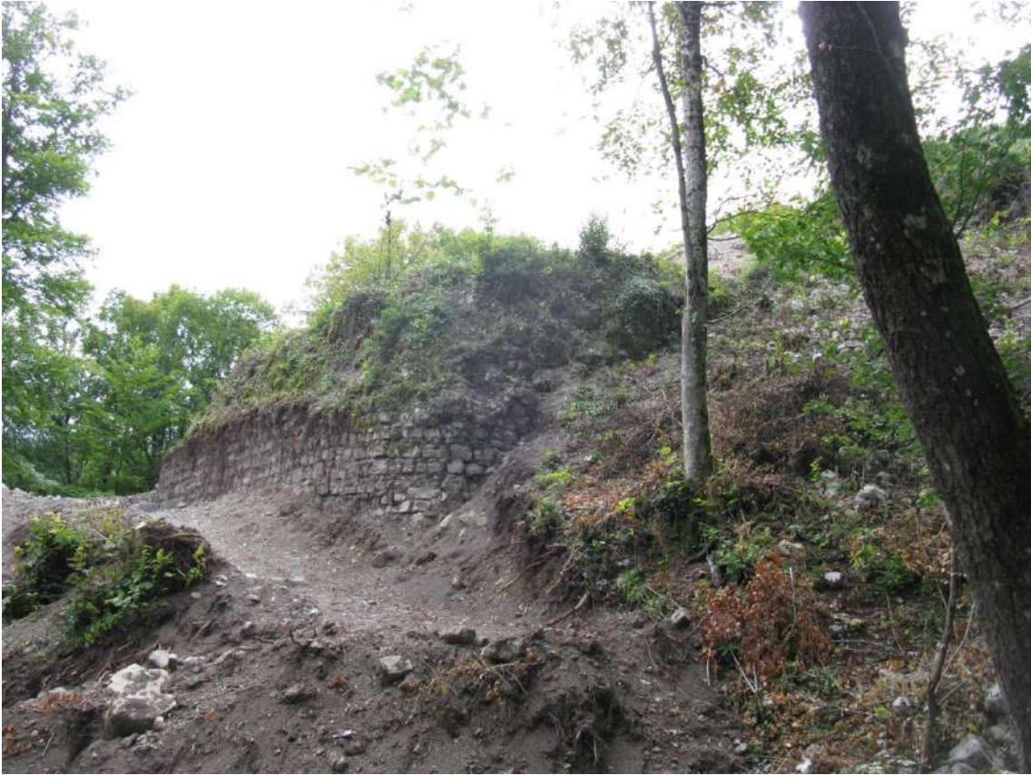
Figure 36 : Le mur M23 avec l'arrondi entre M23 et M25. Etat en 2017.
