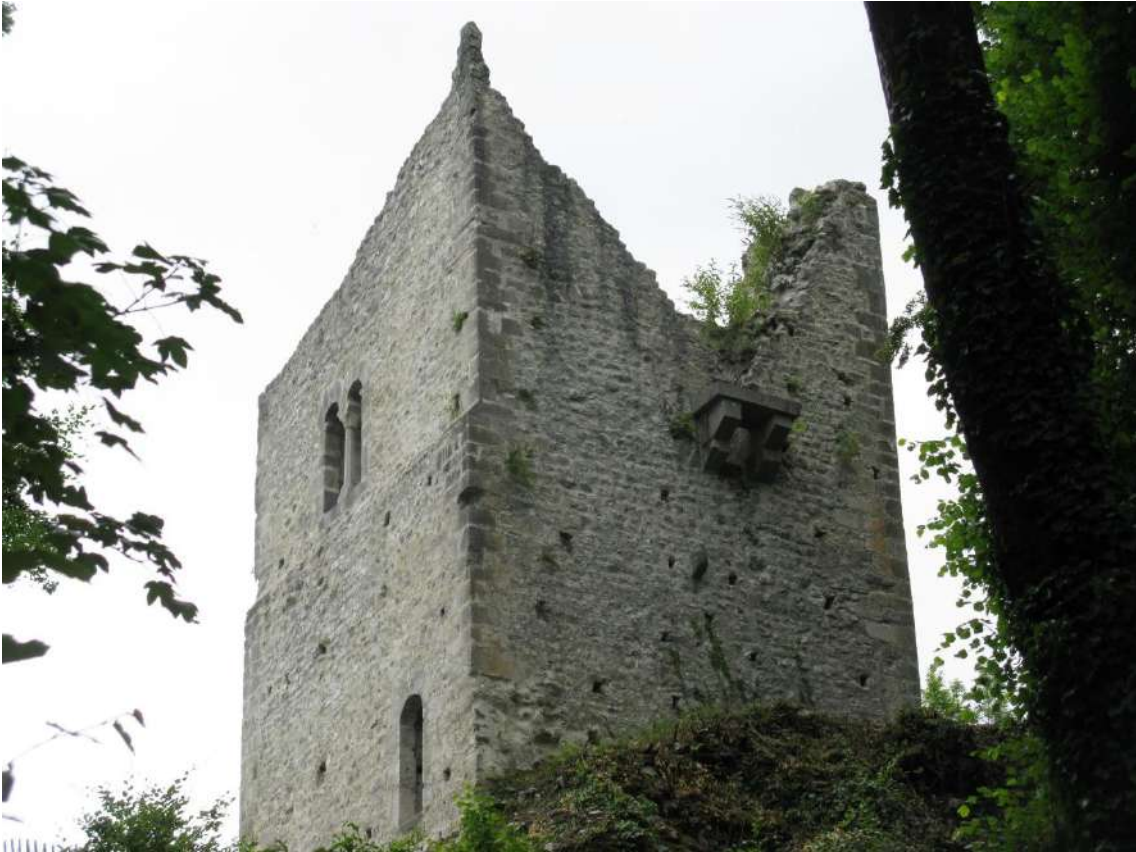
Figure 21 : Angle M03/M04 : le ressaut formant solin dans le mur M03 est bien perceptible.
