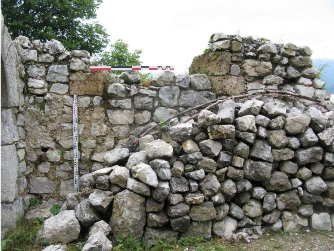
Figure 34 : Vestiges de la fenêtre F10 dans M15. Etat en 2020.
