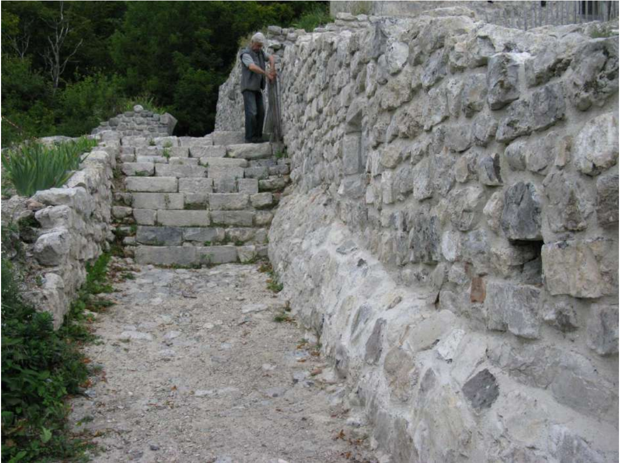
Figure 32 : l’escalier Esc03 et le mur M13/M14, dont les niveaux de fondation sont mis au jour.
