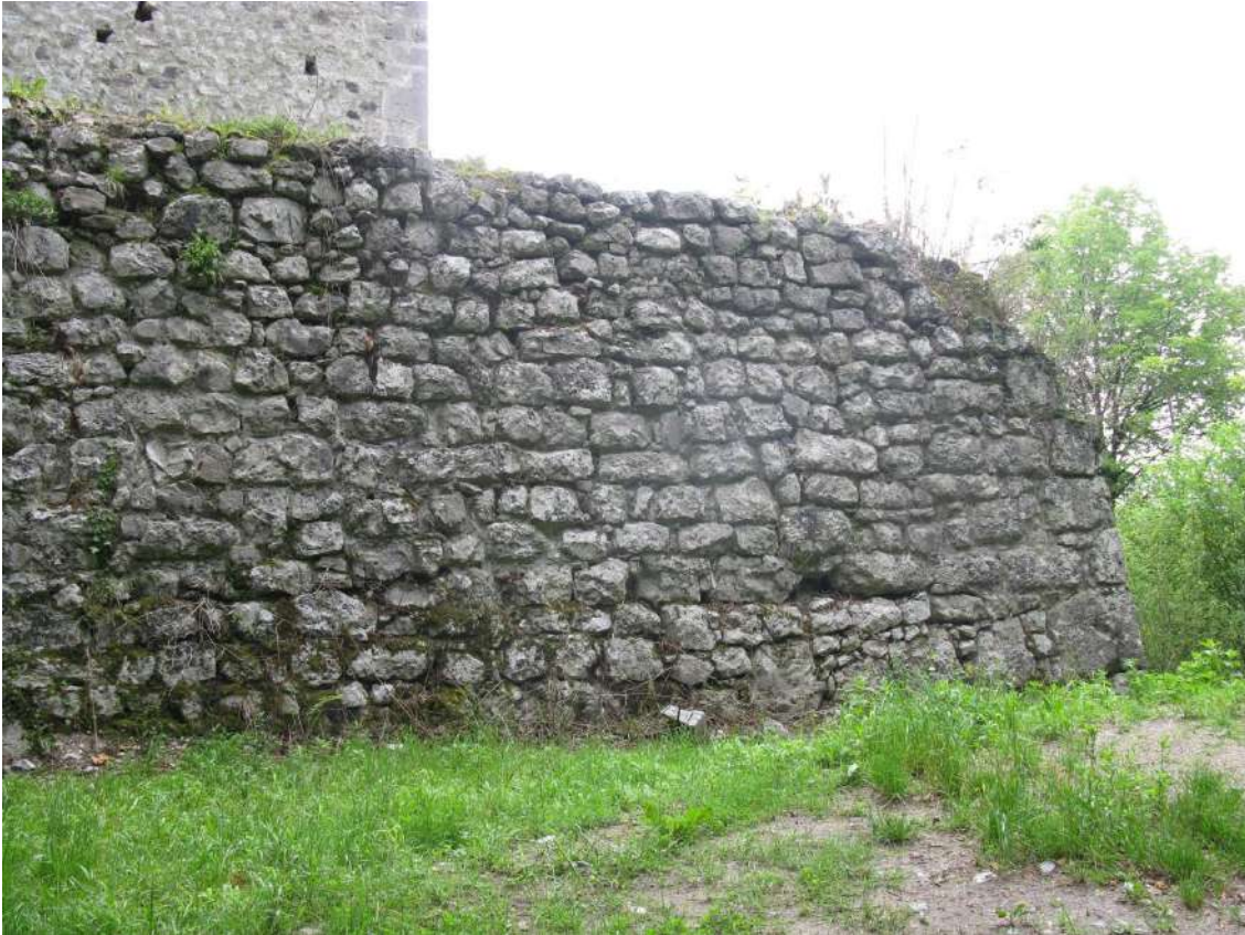
Figure 25 : Le mur de la chemise, M06, partie sud. Photographie 2014.
