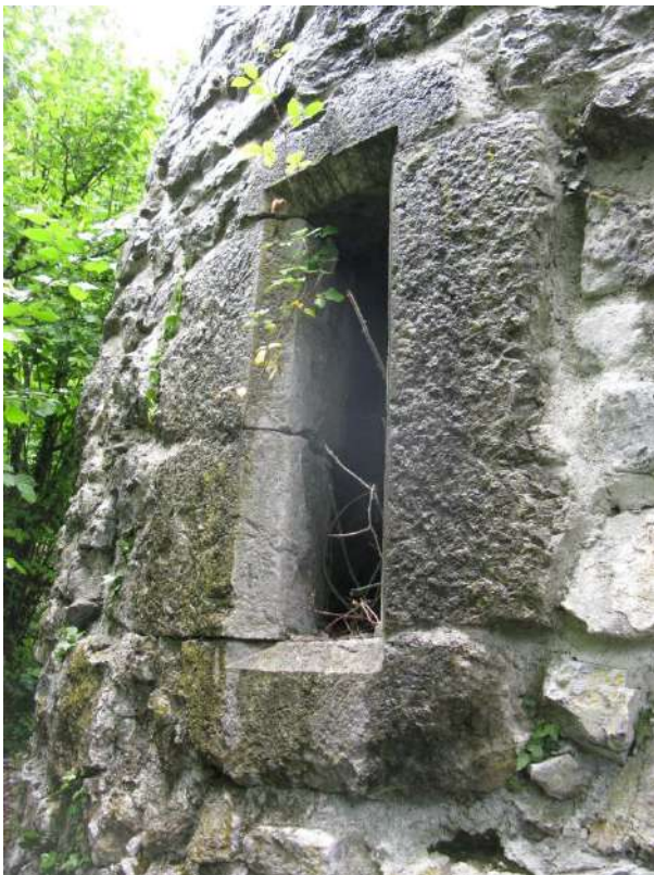
Figure 31 : La fenêtre F07, dans la tourelle M19
