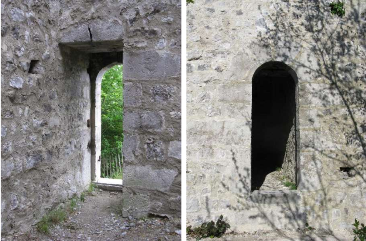
Figure 15 : Porte P01, tour, RDC.
