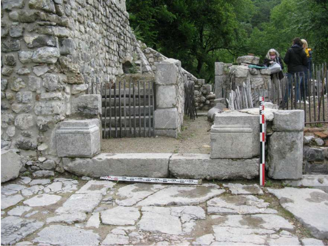
Figure 27 : la porte P05 et l’escalier Esc01. Vue depuis le sud. Mai 2020
