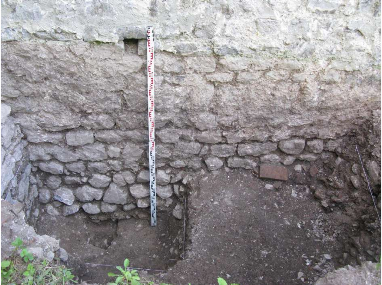
Figure 40 : vue générale du sondage 1 : le mur de la tour (M01) au fond, et le mur du four (M05) à gauche.
