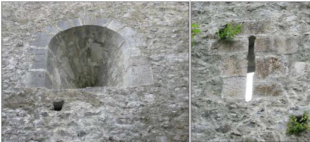
Figure 18 : Arbalétrière du premier étage.
