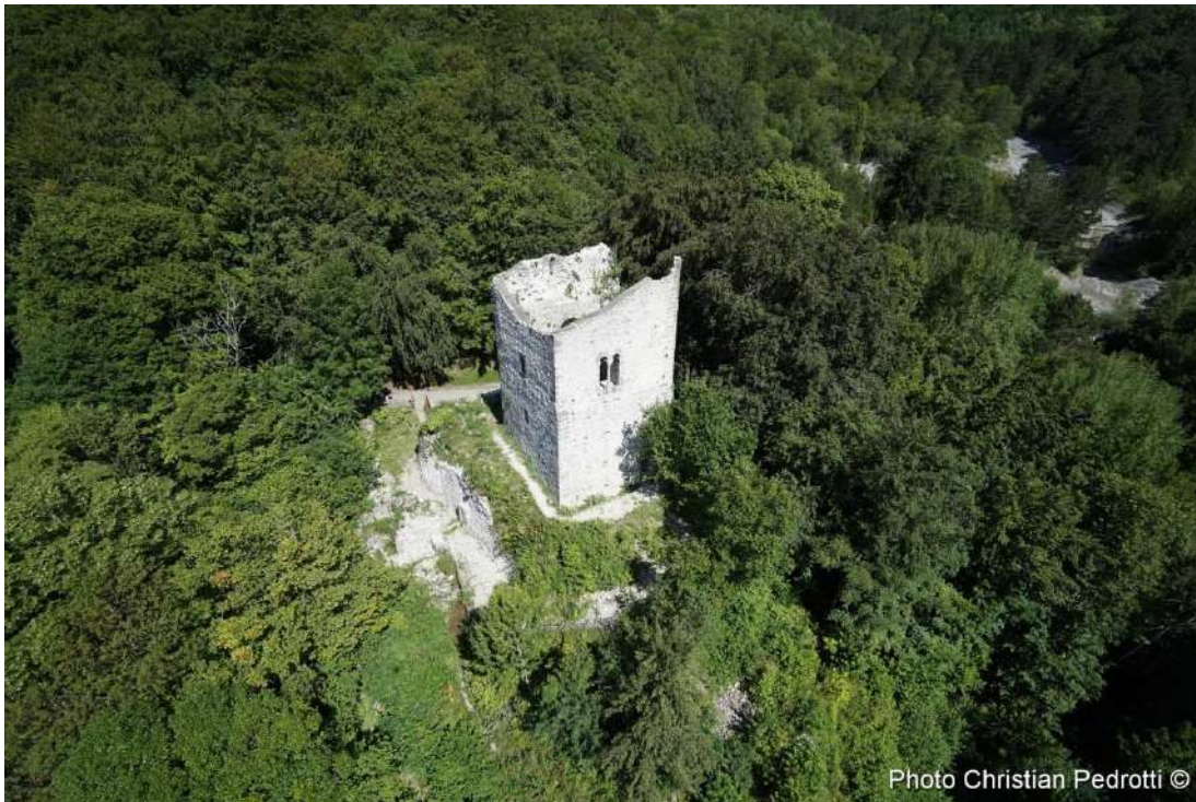
Figure 10 : la tour d’Arces avant les travaux de 2017 ©Christian Pedrotti.
