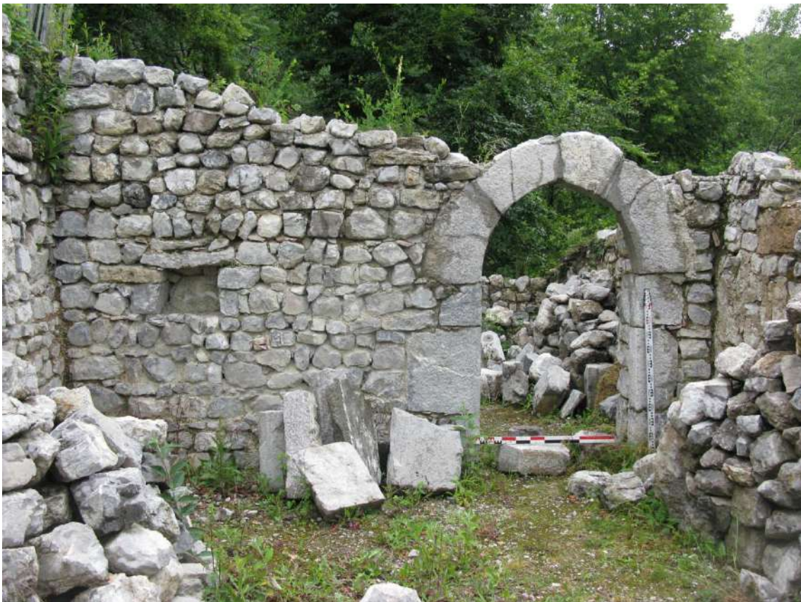
Figure 35 : Mur M17 et porte P12. Etat en 2020.
