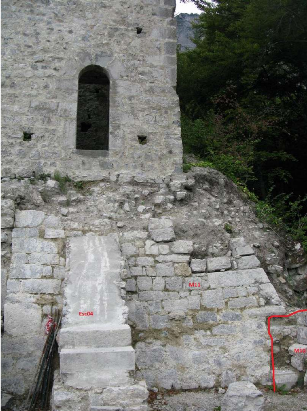
Figure 29 : Le contrefort M11, en appui sur le mur M10.
