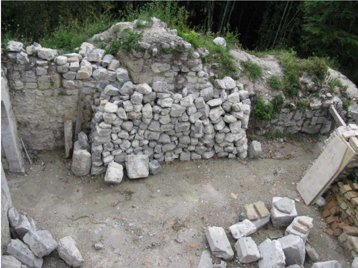
Figure 12 : stockage de blocs taillés et de moellons sur la terrasse 4. Vue en septembre 2017.
