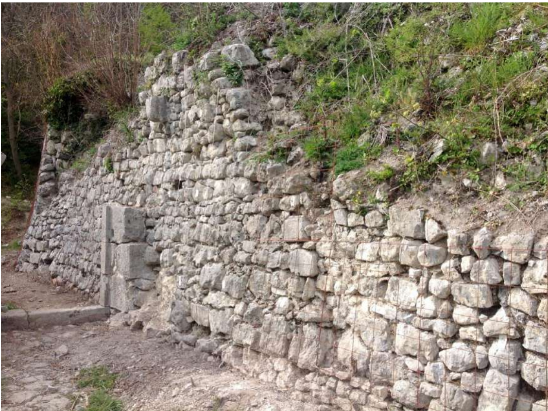
Figure 22 : vue d'ensemble du mur M07, avec la porte P03 au centre, avant les travaux de 2017. Cliché association La Tour d'Arces, 2014.
