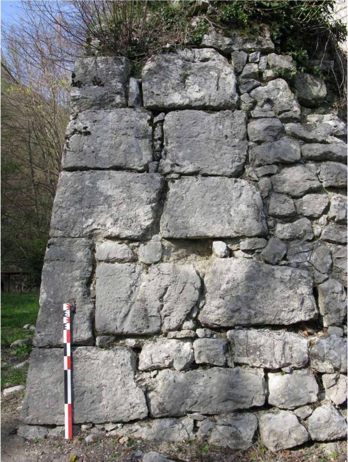
Figure 24 : Le mur de la chemise, M07, angle avec M06, avant les travaux de 2014.
