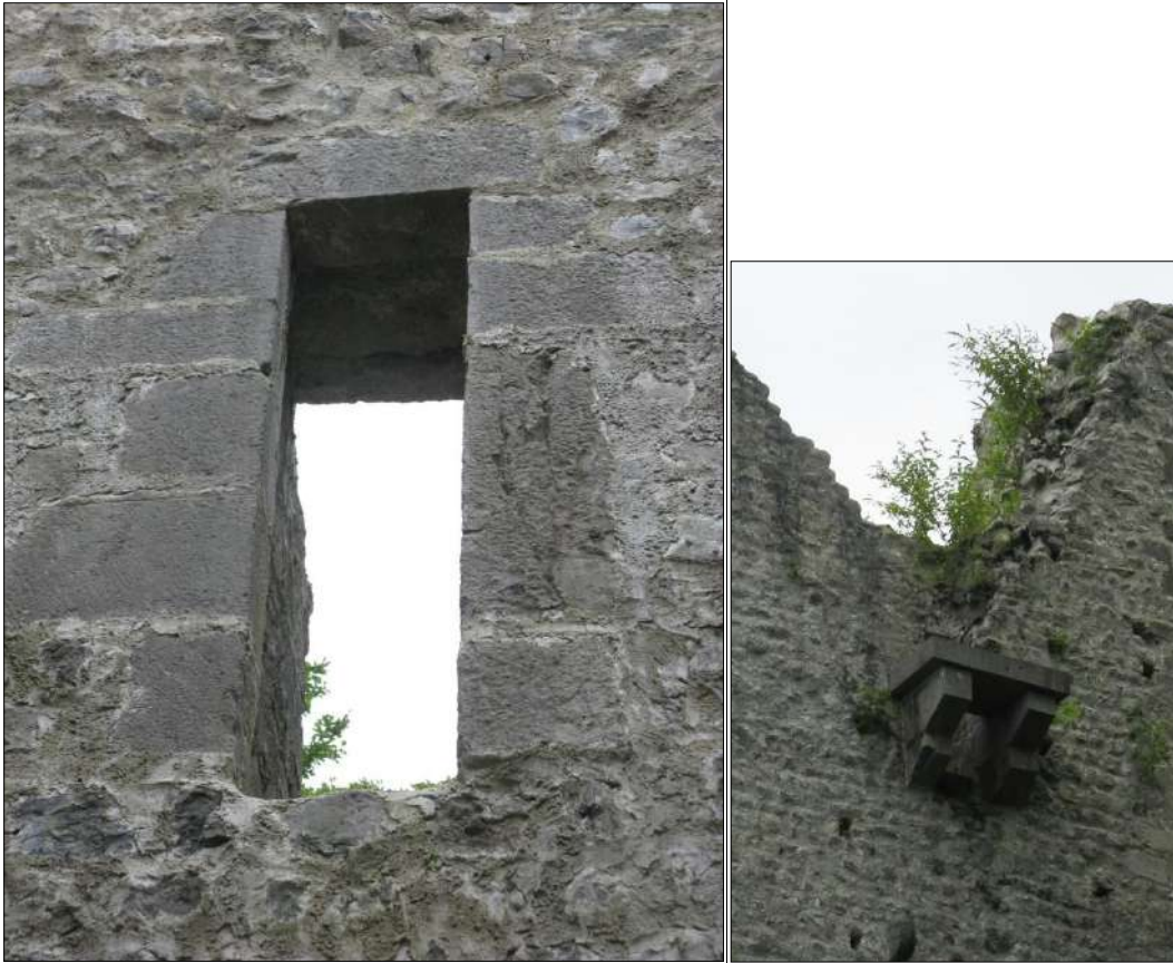
Figure 19 : la porte P02 (des latrines, d’entrée ?), mur nord M04.
