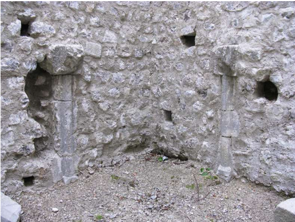
Figure 16 : la cheminée Ch01 (2014).
